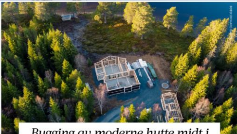
Bygging av moderne hytte midt i Bymarka
